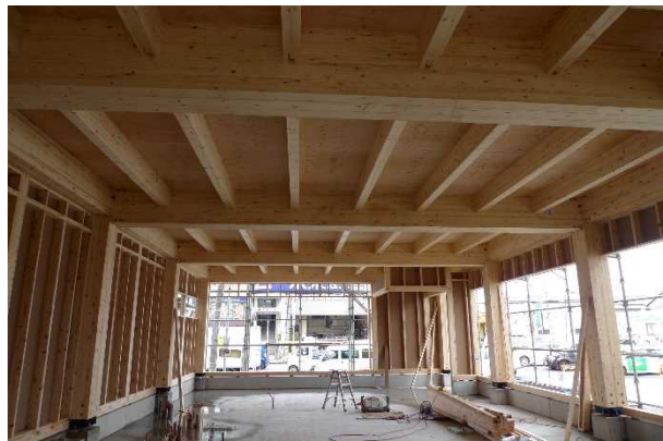
写真① 門の形の骨組みが木造ラーメン構造
