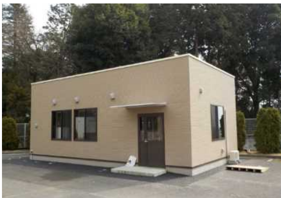
野生いのしし検査棟の外観 (S造平屋建 建築面積約55m 2 )
