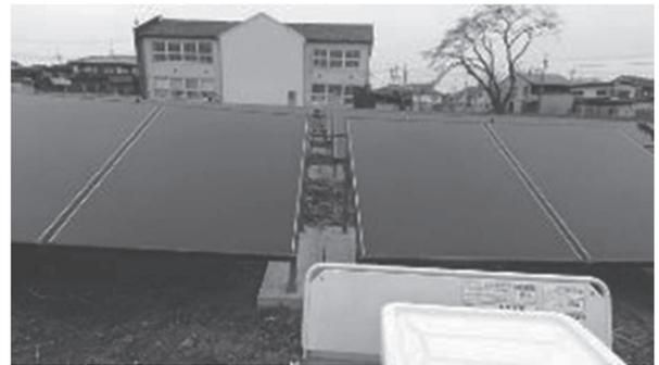
図22 化合物系太陽電池パネル
